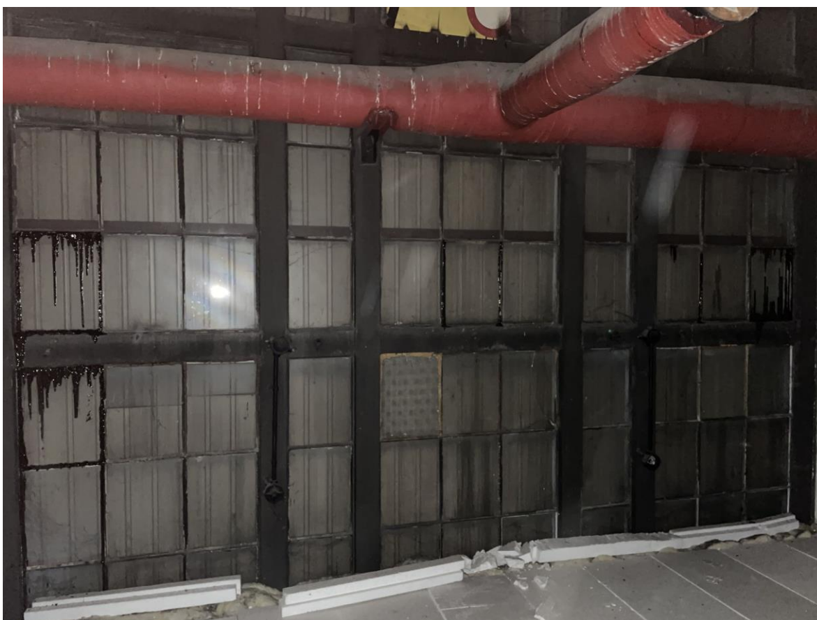
Fot. Widok od wewnątrz na blachę elewacyjną zamocowaną na starej stolarce – elementy do demontażu.
